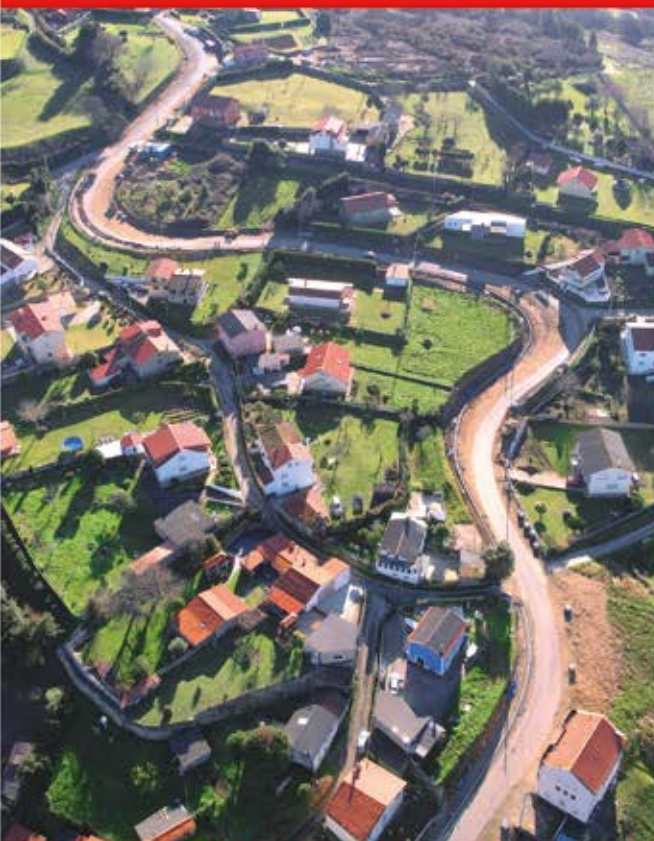
Estrada Ares - Chanteiro, 2ª Fase
